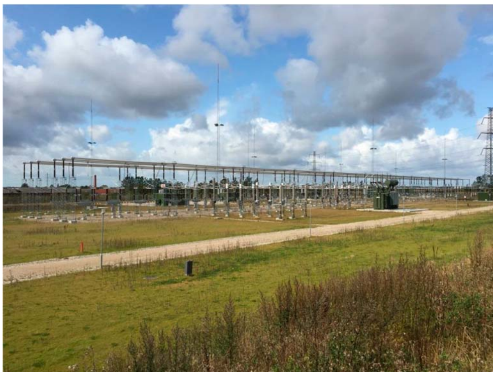
Figur 1-6: Eksempel på AIS-anlæg (Bjæverskov).
